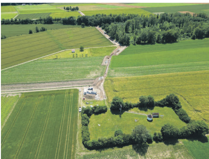
Abbildung 1: Drohnenbild Ing. Büro Wasser-Müller (BC), Pumpwerk Sattenbeuren mit Trassenverlauf
